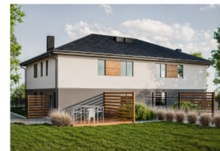
Widok budynku od tyłu
