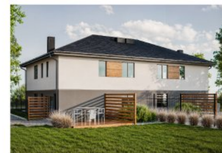
Widok budynku od tyłu
